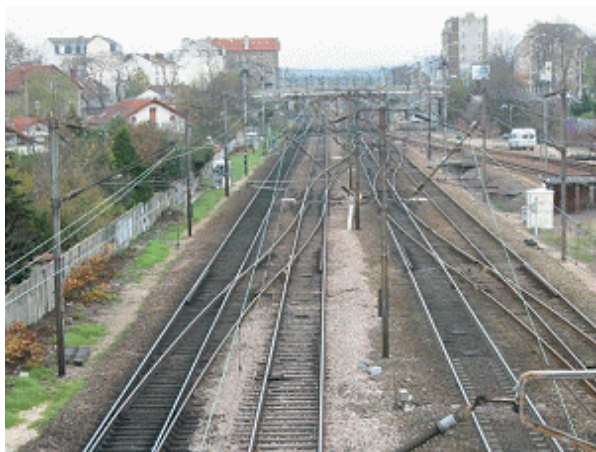
Entrée gare d'Aulnay Sous Bois
