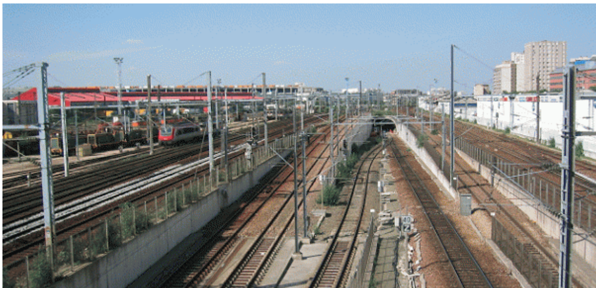
Le débouché du tunnel
