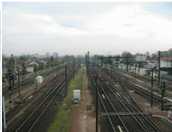
Sortie gare d'Aulnay Sous Bois
