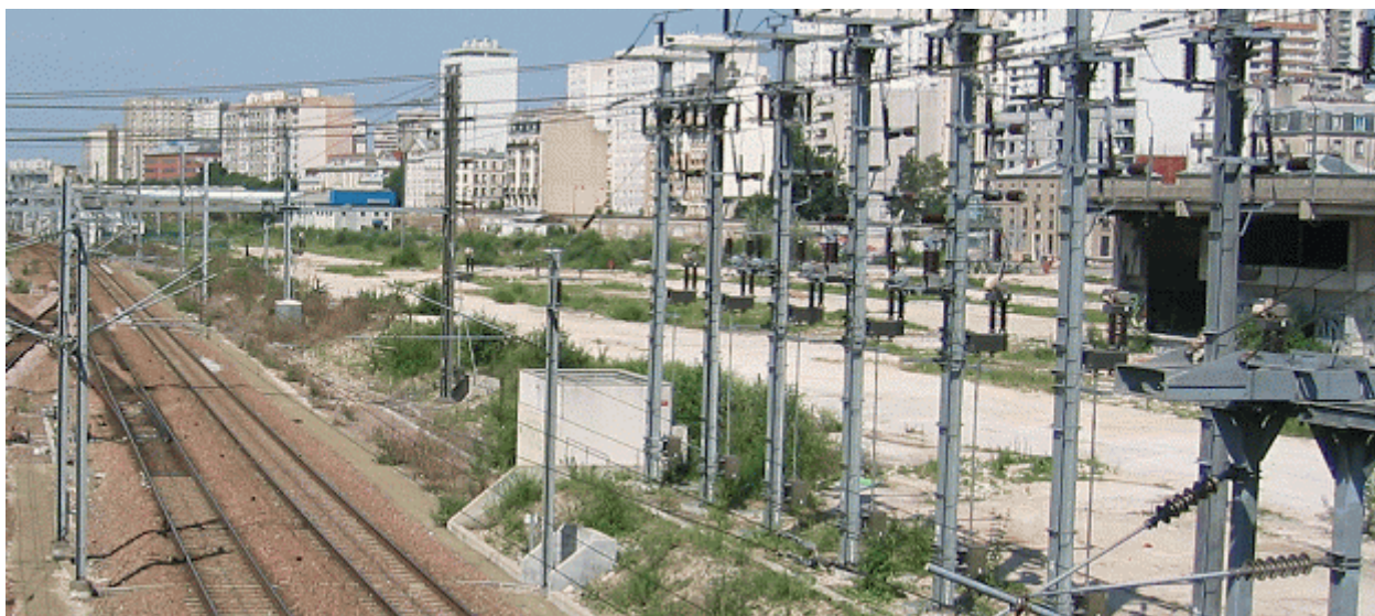
Le débouché du tunnel
