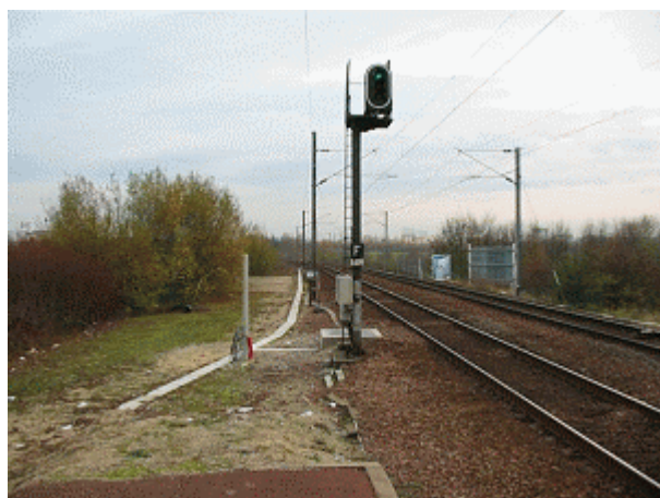
Entrée de la gare de Villepinte
