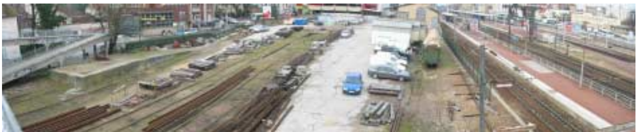
Gare d'Aulnay Sous Bois et sa base travaux
