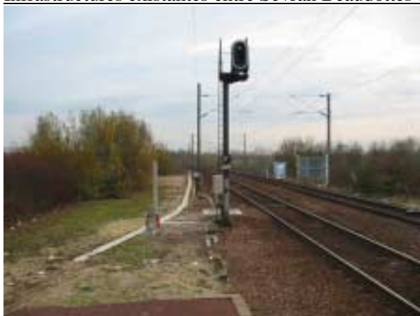
Entrée de la gare de Villepinte
