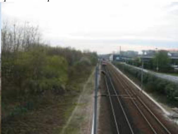
des emprises et des ouvrages d'art qui patientent
