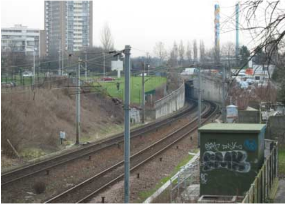
Entrée du tunnel de Sevrans vers Charles de Gaulle
